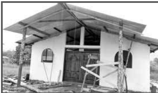
Capilla aún en construcción
